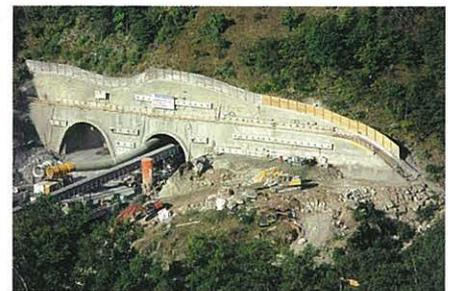
Die zwei Autobahnportale des Tunnels Visp im Chatzuhüs (links) und Vorbereitungsarbeiten für die Lüftungszentrale am Hangfuss.
