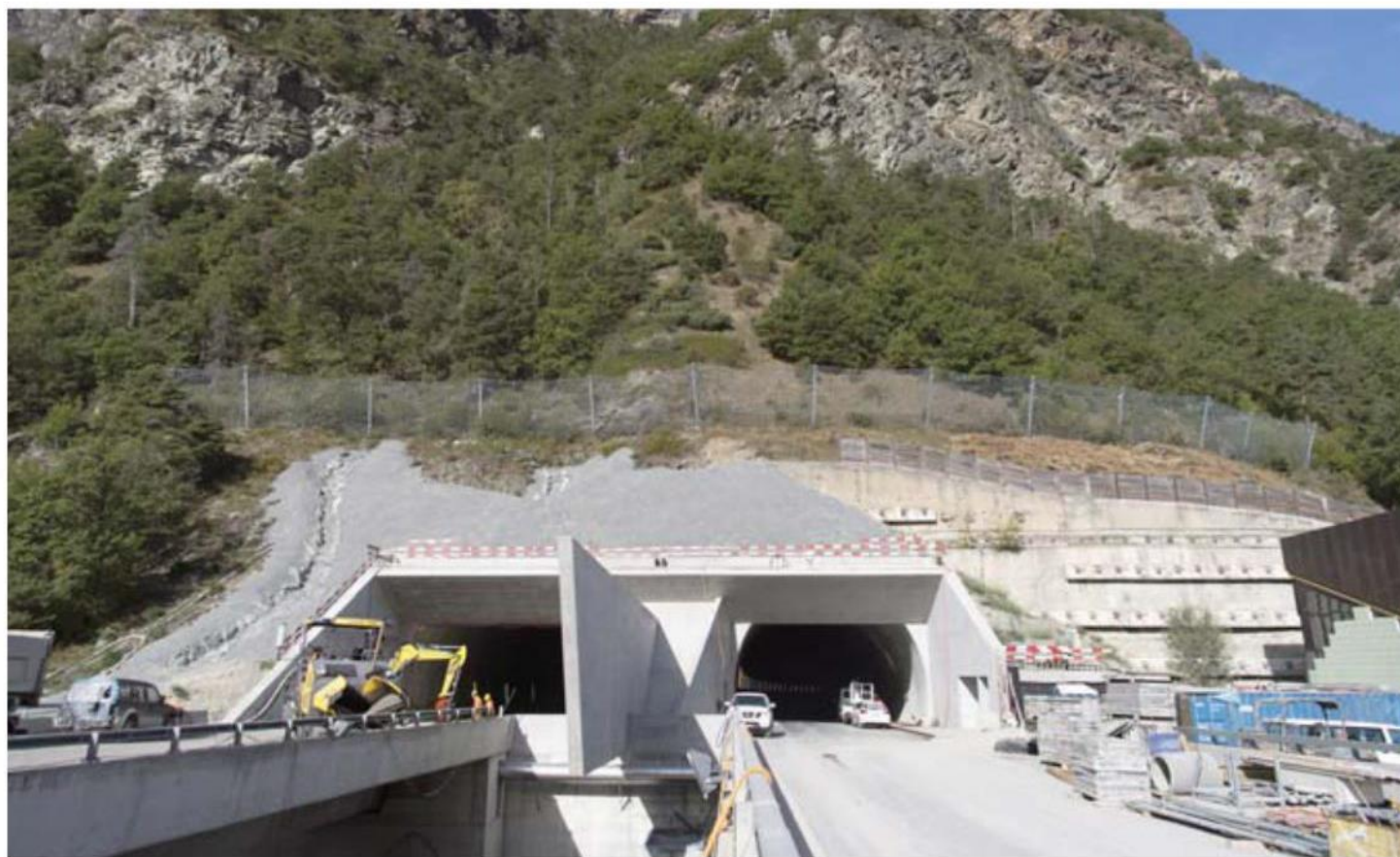
L'entrée du tunnel de Viège lors de la visite du chantier de l'autoroute A9 en construction. KEYSTONE
