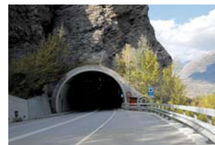
Südportal des bestehenden Vispertaltunnels im Südegg
