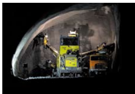
Ein dreiarmer Bohrjumbo beim Einsatz in der Verzweigungskaverne Süd des Tunnels Eyholz.
