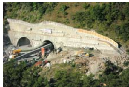
Die zwei Autobahnportale des Tunnels Visp im Chatzuhüs (links) und Vorbereitungsarbeiten für die Lüftungszentrale am Hangfuss.
