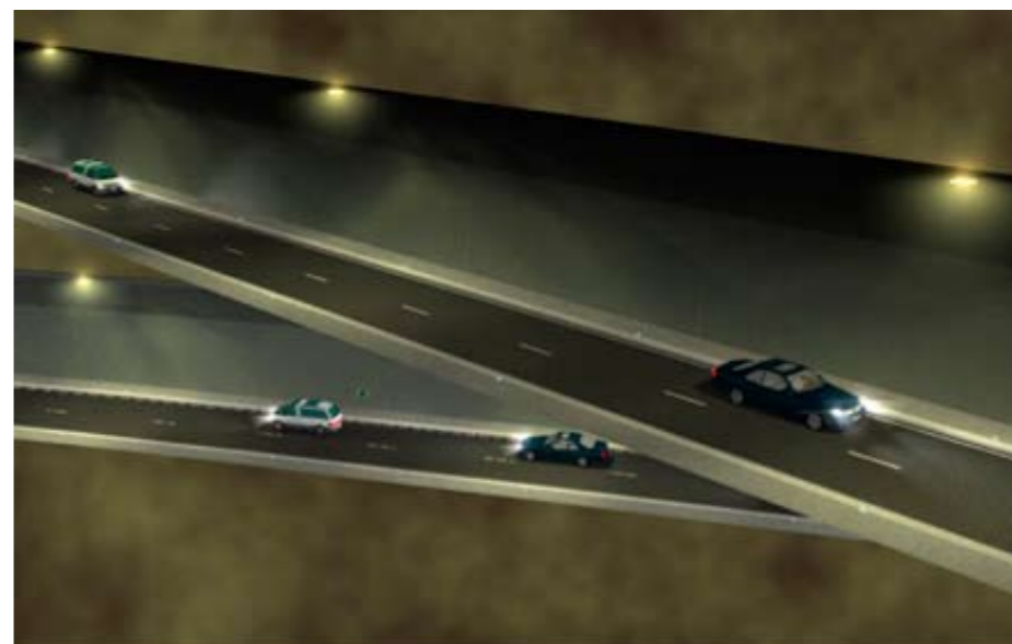
Der Überwurf tunnel überquert die Autobahn röhren im Felsinnern.
