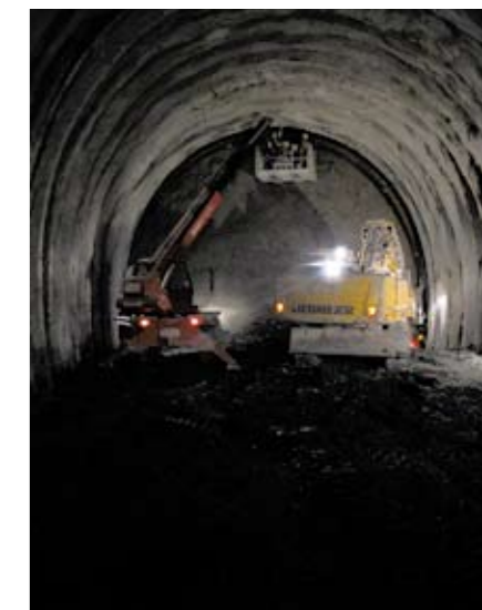
Ausbrucharbeiten im Überwurf tunnel
