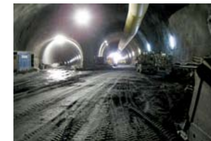
Der Einfahrtstunnel Staldbach (links) führt in die 26 m breite und 15 m hohe Verzweigungskaverne der Südröhre des Tunnels Eyholz
