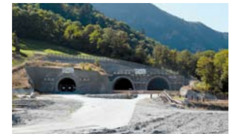
Grosshüs mit dem Portal zum Lüftungstollen (links) und den zwei Autobahnportalen
