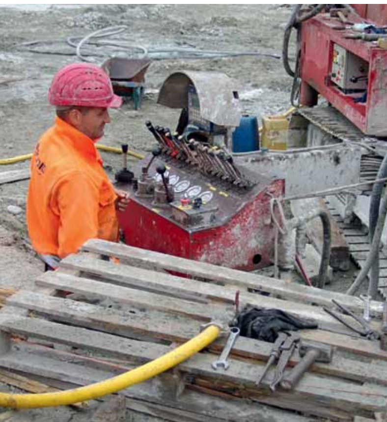
Beim Jettingverfahren werden Säulen von 240 mm Durchmesser auf eine Tiefe von 30 m gebohrt und anschliessend wird Zement unter Druck von 400 bar eingepresst. (Bild: Mediakom)
