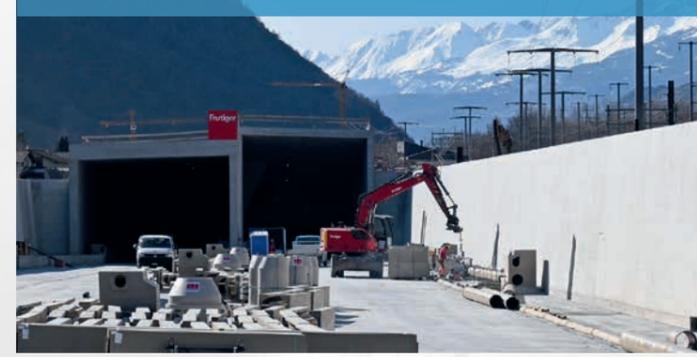
Der Innenausbau des Tagbautunnels ist abgeschlossen. Hier das Ostportal des Gedeckten Einschnittes Raron.
