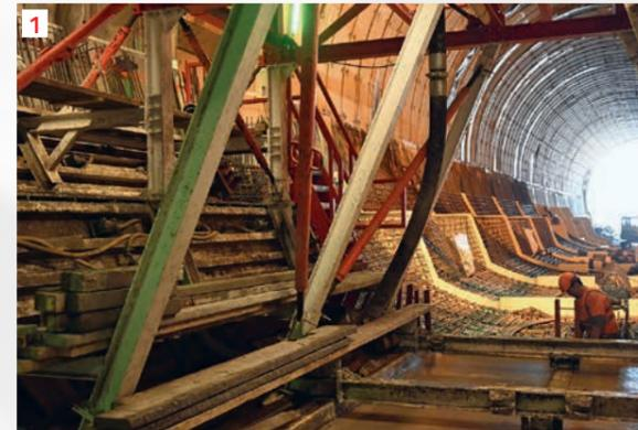
Wagen 1 wird für das Betonieren des Sohlgewölbes verwendet.
