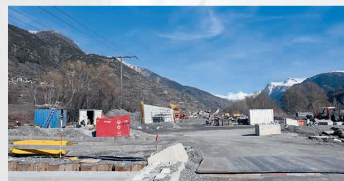
Im Osten des Gedeckten Einschnittes Raron (GERA) entsteht die letzte Stützmauer als Abschluss eines Lärmschutzdammes. Die Arbeiten am Trassee zwischen Raron und der Unterführung St. German werden im Sommer beginnen.
