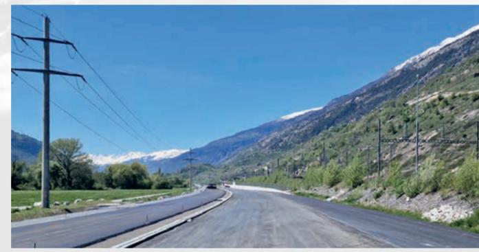
Die ersten Belagsschichten (Trag- und Binderschicht) auf dem Trassee zwischen Visp West und der Unterführung St. German sind eingebaut.
