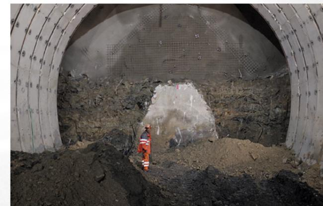
Die Ausbrucharbeiten am Tunnel Riedberg erfolgen kontinuierlich: 80 % der Nordröhre und 70 % der Süd-röhre sind ausgebrochen. Das Ausbruchmaterial verwendet man zur Schüttung des Trasses zwischen dem Tunnel Riedberg (TURI) und dem Gedeckten Einschnitt Raron (GERA).
