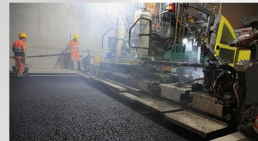
Fahrbahn, maschineller Einbau, Breite 7.30 m.
