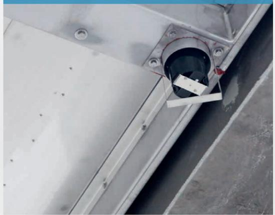
Ähnlich wie in öffentlichen Gebäuden und Büros sind auch an der Tunneldecke Rauchmelder befestigt. Diese haben die Aufgabe, Rauch zu detektieren, um Alarmer auszulösen und andere Anlagen zu steuern, zum Beispiel die Lüftungsanlage zur raschen und zielgerichteten Entrauchung des Tunnels. Bei der Entrauchung gibt es Fälle, bei denen die Ausbreitungsrichtung des Rauches sicher erkannt werden muss. Eine scheinbar einfache Aufgabe, die in Wirklichkeit aber schwierig ist und nicht einfach zu lösen.
