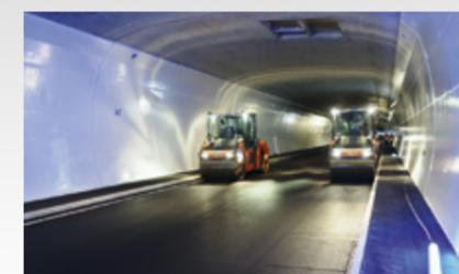
Travaux de revêtement dans le tube Nord du tunnel d'Eyholz.
