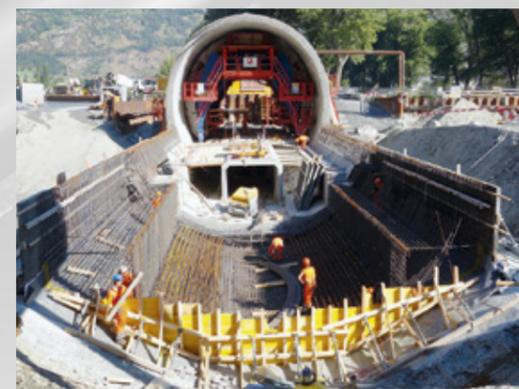
Portail « Schwarzer Graben » : travaux de bétonnage avec des chariots de coffrage.
