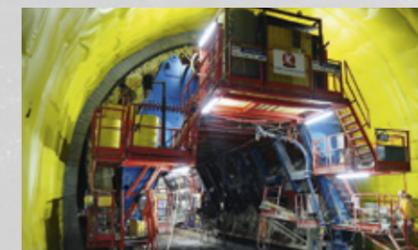
L'anneau intérieur en béton est construit au moyen de chariots de coffrage. En jaune, le lé d'étanchéité dans la zone où aucune armature ne sera posée.
