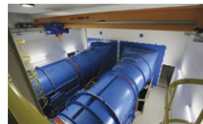
Deux ventilateurs d'air vicié de 8 m de long dans la centrale d'exploitation de Grosshüs.
