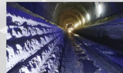
Radier fraisé dans le tunnel de Viège pour l'installation de la galerie technique.
