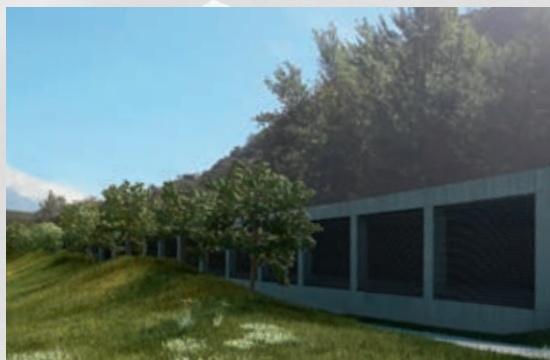
Gedeckter Einschnitt mit seitlichen Öffnungen im Bereich Seeli.
