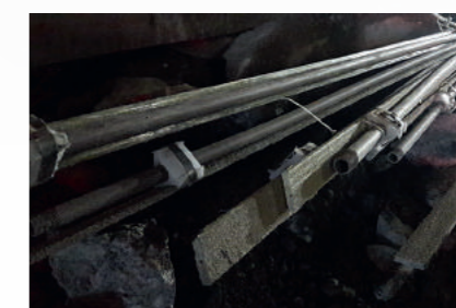
Im Tunnel kommen sogenannte Glasfaser- oder Kunststoffanker (GFK-Anker) zum Einsatz.
