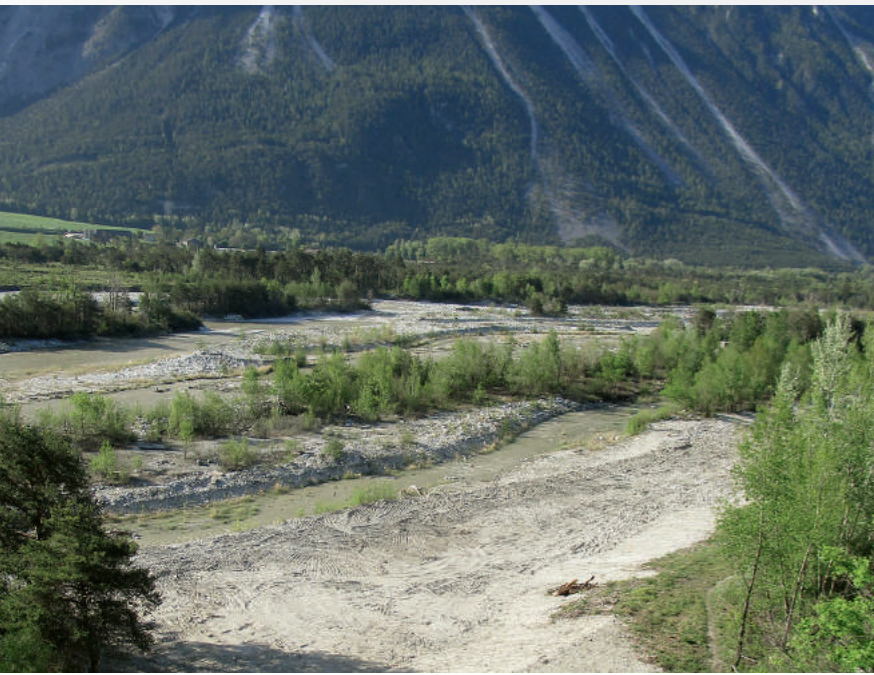
Nach der Überschüttung mit Erdmaterial ist vom Blockwurf nichts mehr zu sehen (April 2018).
