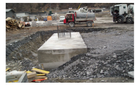
Ein Fundament für einen Signalträger misst 8.50 x 2.50 m.
