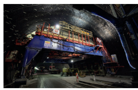
Innenring-Schalwagen in Verzweigung I.
