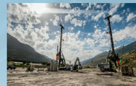
Überschnittene Bohrpfehlwände
