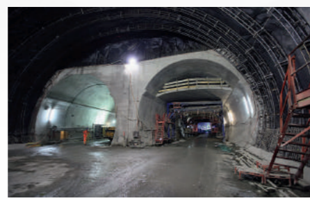
Brillenwand der Verzweigung I, rund 24 m Spannweite, links Überwurf-tunnel, rechts Nordröhre Richtung Staldbach.
