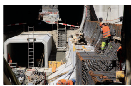
Der Übergang vom Tunnel zur Tagbaustrecke der Nordröhre im Schwarzen Graben wird fertiggestellt.
