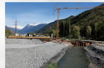
Umleitung Grossgrundkanal für den Bau der Brücke.
