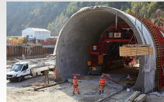
Die Einfahrtsröhren des Nordportals sind betonierte (23.9.2016).
