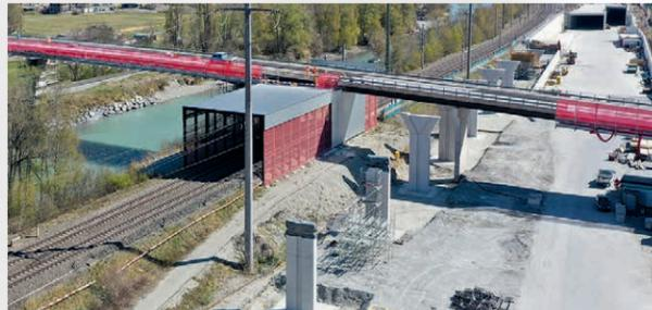
Die Pfeiler der künftigen Rampen, auf welcher die Fahrzeuge in Ost-West-Richtung von der Autobahn ausfahren bzw. auf die Autobahn fahren.
