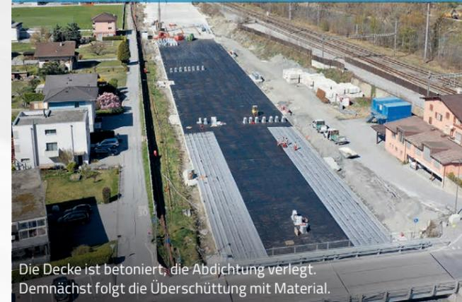
Die Decke ist betoniert, die Abdichtung verlegt. Demnächst folgt die Überschüttung mit Material.
