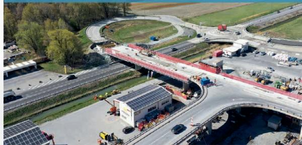
Kernstück des künftigen Vollanschlusses Raron ist die zu sanierende Grossi Brigga Gesch, hier in Turtig. Das Widerlager Süd musste vollständig erneuert werden.
