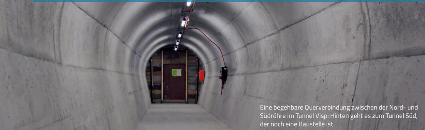
Eine begehbare Querverbindung zwischen der Nord- und Südröhre im Tunnel Visp: Hinten geht es zum Tunnel Süd, der noch eine Baustelle ist.
