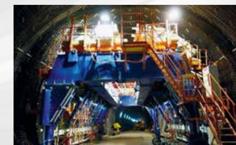
Normale Schalung für den Innenbeton im Tunnel Visp. Die Etappe ist in 1-2 Tagen betoniert.
