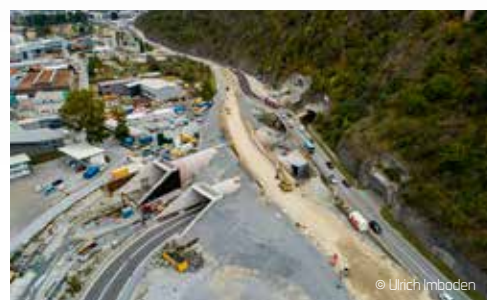
Das definitive Trasse der Kantonsstrasse führt über die beiden Röhren des Tunnels Visp, rechts der Vispertaltunnel.
