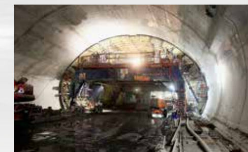
Die ausgeweitete Schalung mit 26 m Spannweite. Eine Beton etappe dauert 1,5-2 Wochen (Beispiel aus dem Tunnel Eyholz).
