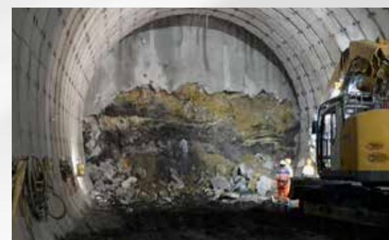
Vortriebs- bzw. Ausbrucharbeiten, Ortsbrust, Tunnelmeter 229.50.
