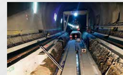
Verlegen des Werkleitungskanals im Tunnel Visp.
