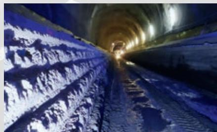
Ausgefräste Sohle im Tunnel Visp für den Einbau des Werkleitungskanals.
