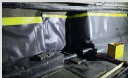
Schwarze Abdichtungsfolie, dort wo eine Armierung verlegt wird.
