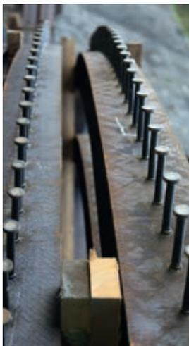
Die H-Profile sind oben mit speziellen Dübeln versehen. Sie können während der ganzen Lebensdauer des Tunnels allfällige Verschiebungen abfedern.
