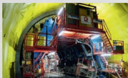
Mittels Schalwagen wird die Innenbetonschale erstellt, gelb die Abdichtungsfolie im Bereich, in dem keine Armierung verlegt wird.
