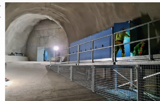
Montage der Schaltschränke.
