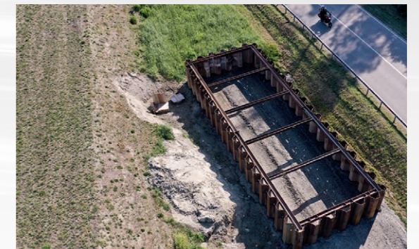
Die SABA entsteht: Strassenabwasserbehandlungsanlage Schnidrigu.
