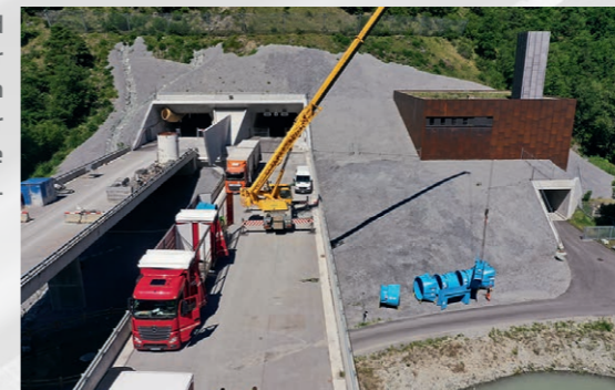
Ablad und Transport einzelner Teile des grossen Ablüfters der Betriebszentrale Chatzuhüs.
