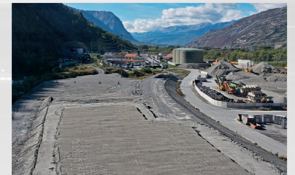
Trasse- und Gestaltungsarbeiten, vor dem Ostportal in Ausführung.
