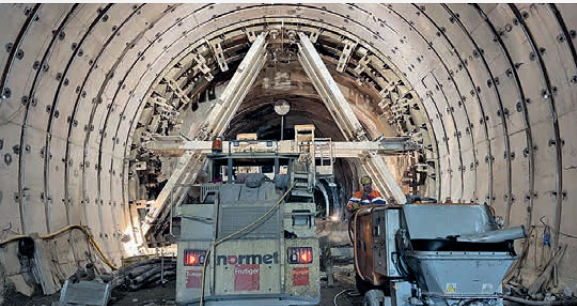
Versetzen der Stahlelemente für die Schalung der Ausbruchsicherung und Verstreibungsmassnahmen während der Bauphase (Nordröhre). Sichtbar sind die Stahlbögen der Ausbruchsicherung. Später erfolgt das Betonieren des Innenrings.
