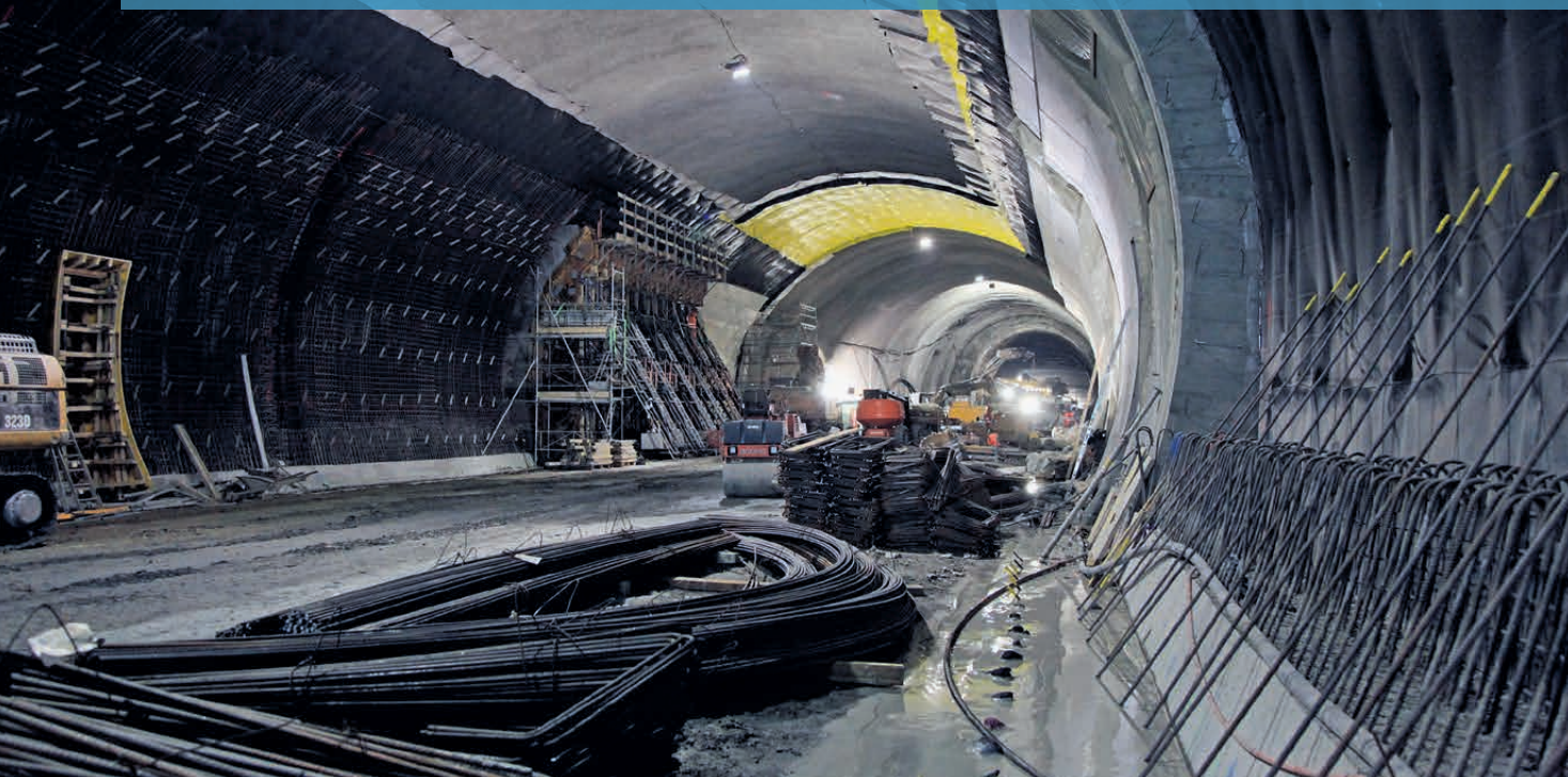
Verzweigung II Tunnel Visp.
