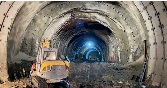
Nach erfolgtem Bohren des Rohrschirms und dem Entfernen der «alten» Ausbruchsicherung wird der «neue» Spritzbeton als ein Teil der Ausbruchsicherung aufgetragen.
