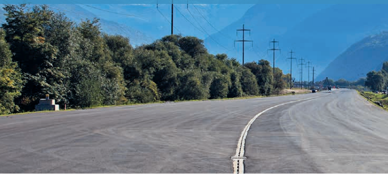
Offene Strecke Schnidrigu – Turtig im Herbst 2021. Dritte Belagschicht (Verschleiss-Schicht), in der Mitte die Schlitzrinne zum Auffangen der Strassenabwässer.
