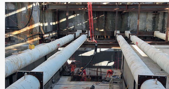
Die Bauarbeiter erstellen am tiefsten Punkt des Tunnels den Pumpschacht der Pumpstation.
