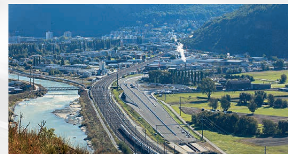
Die Arbeiten am Trasse zwischen Visp West und der Unterführung St. German haben im November 2021 begonnen.
