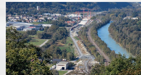
2023 ist geplant, mit dem Bau der letzten Strecke der Autobahn A9 zwischen Brig und Susten zu beginnen: Dem Trasse zwischen Ostportal GERA und Unterführung St. German.
