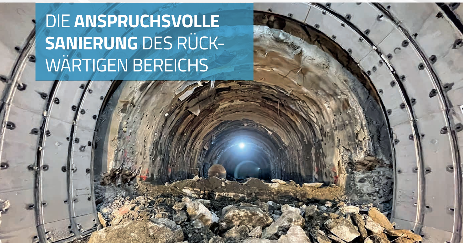
So präsentierte sich die Südröhre des Tunnels Riedberg im «alten» Teil, im sogenannten «rückwärtigen Bereich», zu Beginn der Sanierungsarbeiten.
