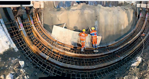
Nach dem Aushub des unteren Teils des Tunnels erfolgt der Einbau des Sohlgewölbes. Insgesamt müssen im rückwärtigen Bereich rund 10'000 m³ Sohle ausgehoben und 1'500 Stahlbögen gesetzt werden.
