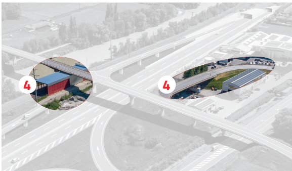
Rückbau SBB-Schutztunnel und Zufahrt Rampe Turtig.
