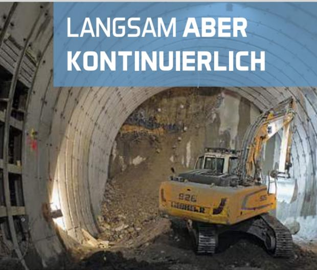
So kurz er auch ist – der Bau des Tunnels Riedberg hat es in sich. Mittlerweile sind rund 70 % der Nordröhre und rund 60 % der Südröhre ausgebrochen.
