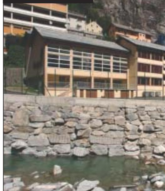
Die Fundamente der Ufermauern der Doveria im Bereich des Dorfes Gondo werden 3 Meter unter dem Niveau des Bachbettes angelegt, um Unterspülungen zu verhindern. Die Mauern überragen maximal 8 m das Bachbettniveau; die Mauerstärke beträgt bis zu 3 m.
