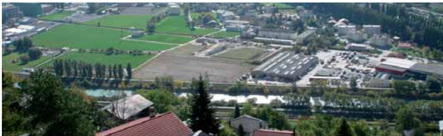
Die Wohnqualität des Kleegärtenquartiers in Visp wird dank der neuen Strasse markant verbessert.
