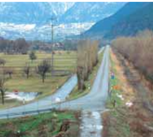
Der rechtsufrige Rhonedamm wird bis zu 35 m nach Norden verschoben. (Foto ab Laldnerbrücke in Richtung Osten)
