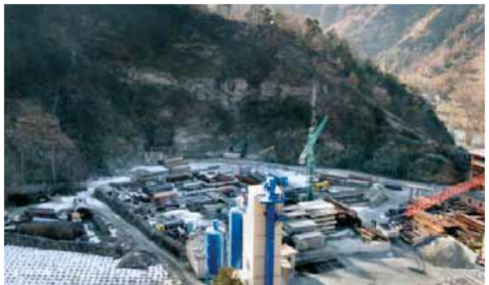
Die Felsnase südlich des Portals Staldbach vor dem Felsabtrag.
