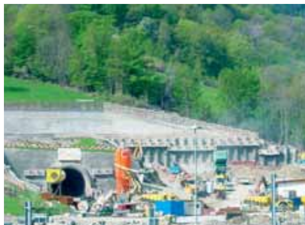
Der 403 m lange Lüftungsstollen im Grosshüs liegt südlich der beiden Hauptröhren und ist bereits ausgebrochen.
