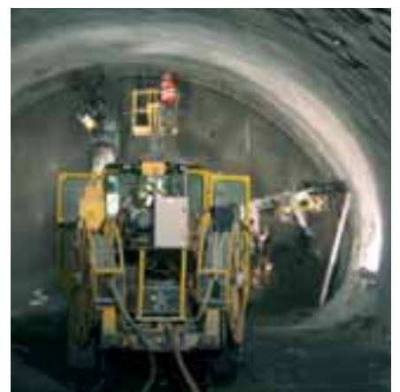
Arbeitsort von Heiko Busch: Bohrwagen zum Setzen von Spiessen und Anker im Lüftungsstollen Grosshüs.
