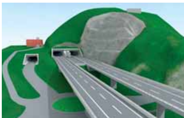
Das Landschaftsmodell von Staldbach zeigt die Portale der A9-Tunnels Eyholz und des Ausfahrtstunnels sowie die Lüftungszentrale im Endzustand.
