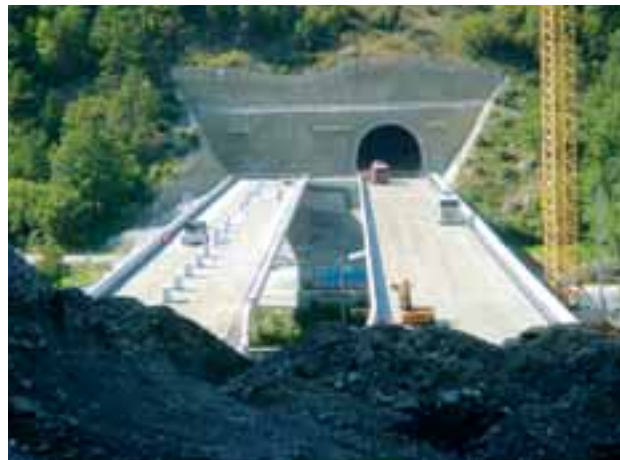
Das Portal Chatzühüs mit dem Eingang zum Schutterstollen, der die zukünftige Nordröhre des Tunnels Visp bildet.
