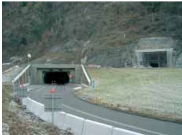
Das Portal Schwarzer Graben des bestehenden Vispertaltunnels, der im westlichen Teil auf einer Länge von 1'829 m die zukünftige Südröhre des Tunnels Visp bildet (rechts die Lüftungszentrale).
