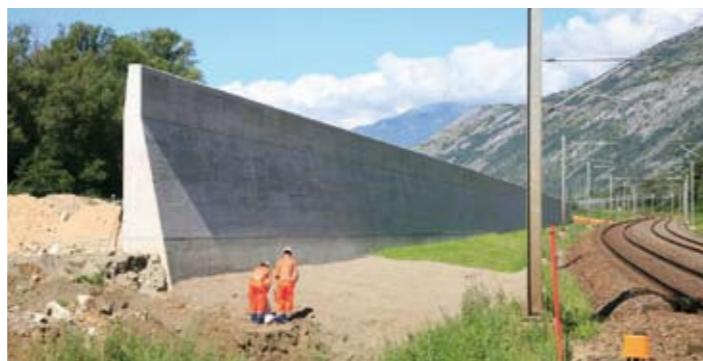
Die 186 m lange Stützmauer bei Tennen.
