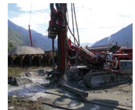
Jettingsohlengerät im Einsatz.
