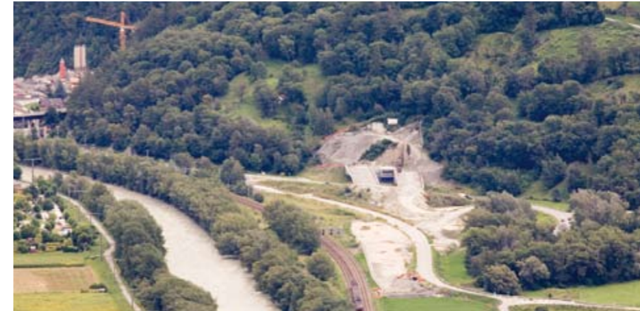
Der Bereich des Westportals wird mittels vertikalen Jettingbohrungen stabilisiert.
