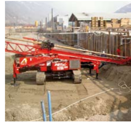
Mit dem Jettingankergerät werden die Spundwände seitlich verankert.
