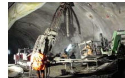
Bohrmaschine für Drainagebohrungen.
