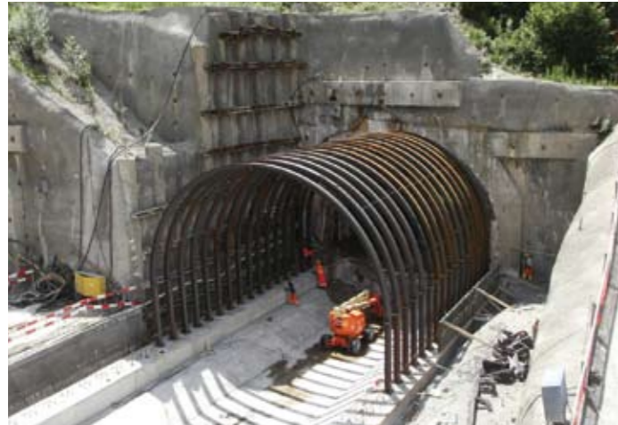
Nordröhre des Ostportals mit Fundamentplatten und aufgebauten Stahlbögen.
