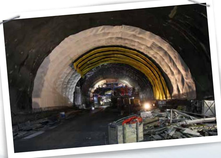
Abdichtung und Innenbetonarbeiten in der Verzweigung Süd des Tunnels Eyholz.
