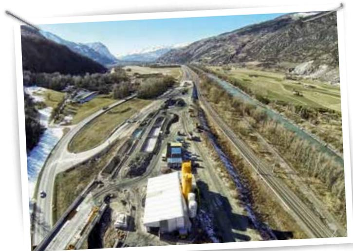
Infolge des instabilen Geländes sind auf der Westseite des künftigen Tunnels aufwändige Stabilisierungsmassnahmen notwendig. Wie im letzten A9-Info (Nov. 2013) im Detail beschrieben, müssen zur Stabilisierung des Hanges Bohrungen getätigt werden, welche die Arbeiter mit einem Wasser-Zement-Gemisch auffüllen. Rund 50%, das heisst 22'500 von 45'000 dieser Jettingsäulen waren Mitte Mai 2014 erstellt. Diese Arbeiten dauern noch bis Ende 2014.
