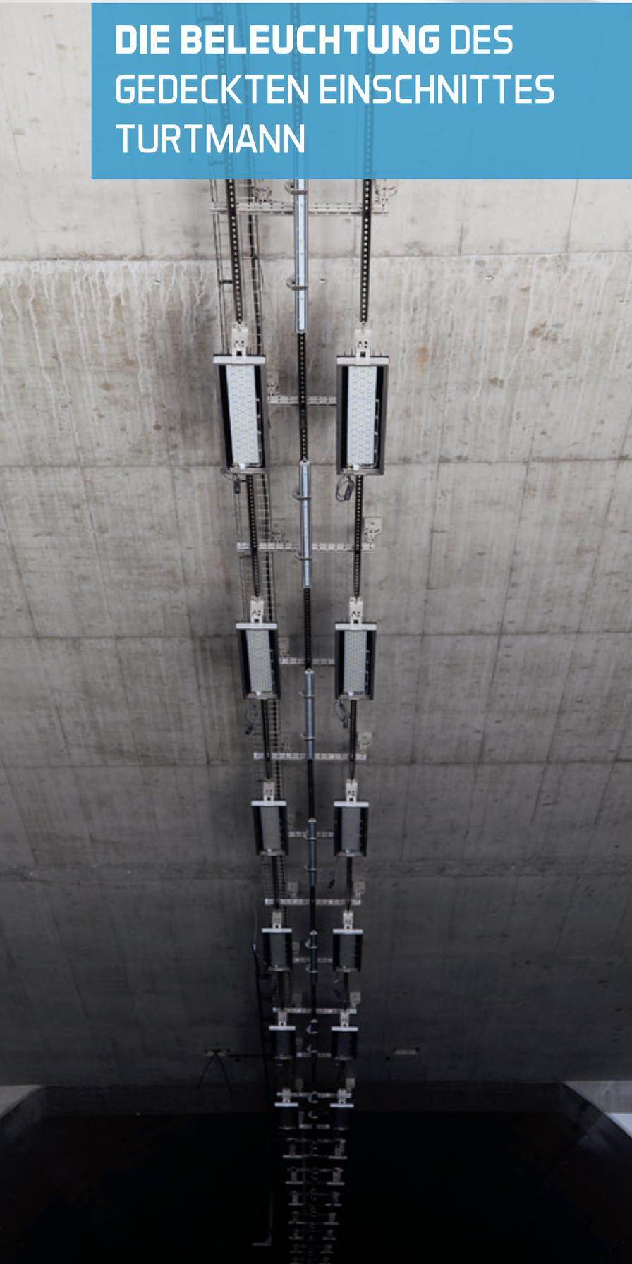
Am Beispiel der Beleuchtung zeigt sich die Vielfalt der betriebs- und sicherheitstechnischen Ausrüstung der Autobahn, hier im Tunnelbereich. Komplex wird es, wenn die einzelnen Elemente bzw. Komponenten reibungslos zusammenspielen und funktionieren müssen. Eine Aufgabe, welche die Leittechnik übernimmt. Deren Rechner sind in der Betriebszentrale bzw. in den technischen Lokalen zu finden.
