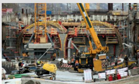
Betonieren des Tunnelgewölbes (2013).
