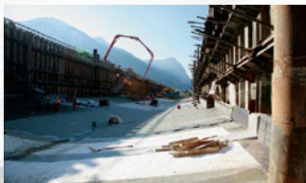
Gedeckter Einschnitt Turtmann (GETU) 2012: Das Sohlgewölbe wird betoniert.
