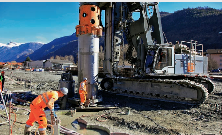
Grossbohrgerät zum Erstellen der Bohrpfähle.
