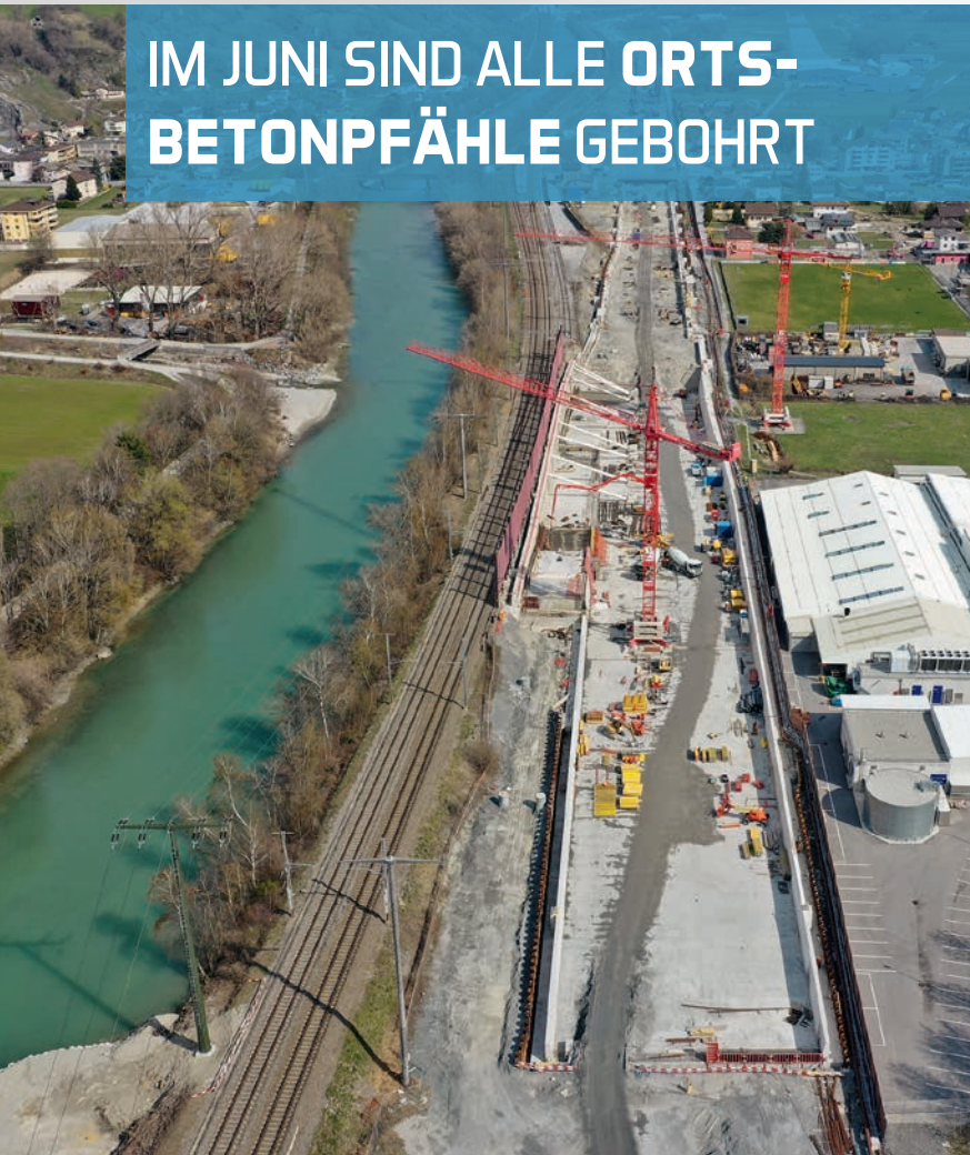
Westliche Einfahrtsstrecke (Wanne West) des GERA.
