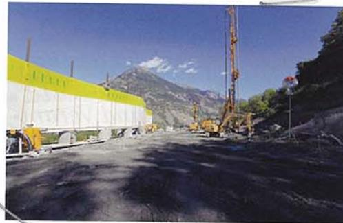
Das Bohrgerät auf dem geschütteten Material oberhalb des künftigen Westportals des Tunnels Riedberg.
