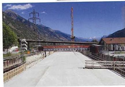
Dieselbe Stelle im **September 2013**, aber von der anderen Seite. Der Tagbautunnel ist fertig betoniert und wird nun zugeschüttet.
