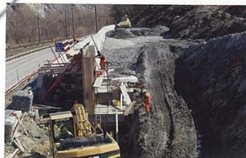
Die neue Erdgasleitung der Swissgas mit Steinkorbmauer und Stützmauer im Bau (im März 2013). Heute ist der ganze Teil rechts der Korbmauern mit Material überschüttet (vgl. Skizze auf S. 4).
