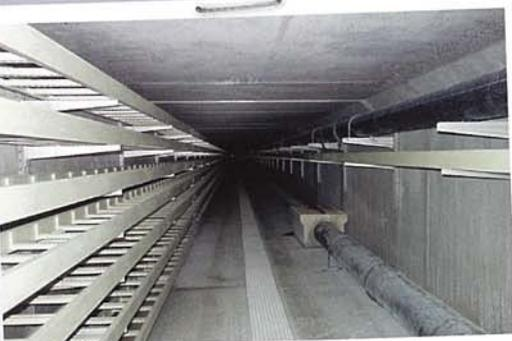
*Begehbare, 2.10 m hohe Werkleitungskanäle in der Sohle des Tunnels Eyholz. Links die Kabeltrassen für die späteren Kabel, rechts unten die Bergwasserleitung, welche das Wasser aus dem Berg ableitet und oben die Löschwasserleitung.*
