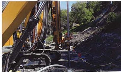
Die Löcher werden rund 30 m in die Erde gebohrt. Beim Herausziehen spritzt (injiziert) das Bohrgestänge (Lanze) Zement in das Erdreich rund um den künftigen Tunnel.
