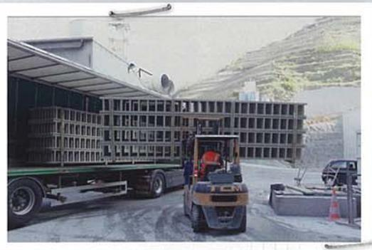
*Lieferung der Kabeltrassen für den Tunnel Eyholz auf der Baustelle im Staldbach bei Visp.*
