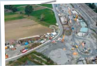
Baustelle Grosseya: Gut sichtbar die Bauarbeiten im Grundwasser, beim Erstellen der Auffahrt nach Sitten (rechts) und der Abfahrt nach Visp (links) der künftig in der Mitte durchführenden Autobahn. (Foto: Swissgas)
