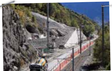
Steinkorbmauer beim Einfahrtstunnel Staldbach.
