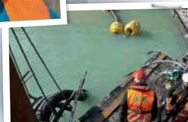
Mit einer Schlammpumpe wird der Schlamm vom Boden abgesaugt und durch eine schwimmende Leitung in ein Absetzbecken gepumpt.
