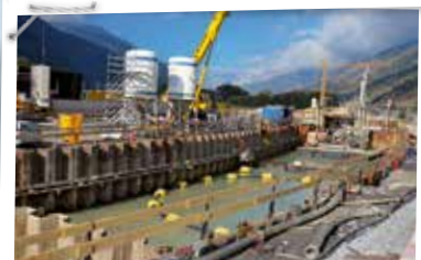
Die künftige Zufahrt zur Autobahn von Visp West nach Sitten entsteht zur Zeit im Grundwasser.
