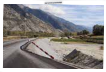
Trasseeschüttungen im Osten des Tunnels Riedberg. Ein Teil der Autofahrt auf die Autobahn wurde bereits erstellt.
