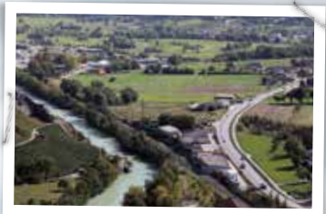
In rund 2½ Jahren soll das nächste A9-Teilstück im Oberwallis (Susten Ost – Gampel West) in Betrieb gehen.
