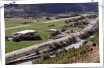
Erste Trasseeschüttungen zwischen der Ausfahrt des künftigen Gedeckten Einschnittes Raron und Visp West.
