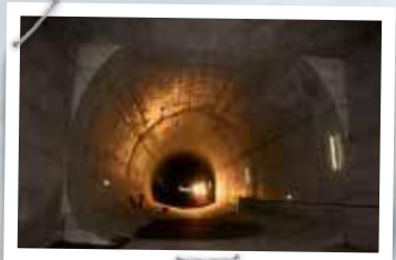
Der Innenausbau im Gedeckten Einschnitt Turtmann verläuft programmgemäss.
