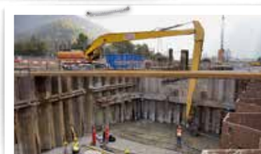
Bodenplatte konventionell (ohne Unterwasser-Beton).
