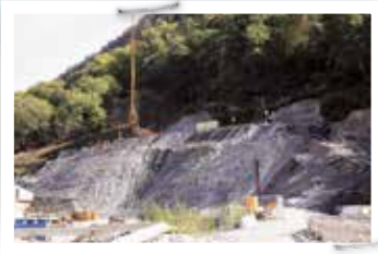
Die Stabilisierungsmassnahmen am Riedberg sind grösstenteils beendet: Rund 27'500 t Zement sichern das Lockergestein, damit die Wiederaufnahme der Vortriebsarbeiten im Tunnel 2015 erfolgen können.
