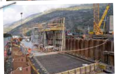
Betonieren der Bodenplatte und der Seitenwände.
