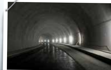
Der fertig betonierte Einfahrtstunnel Staldbach kurz nach dem Tunnelportal.
