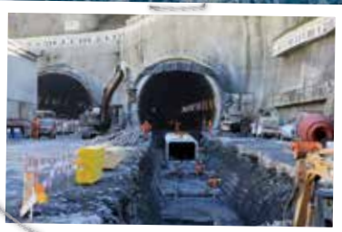
Portal des Tunnels Eyholz im Staldbach: Auf der Sohle werden die Elemente des begehbaren Werkleitungskanals versetzt.
