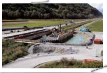
Der Kreisel Turtig wird als Überführung über den Grossgrundkanal konstruiert und dient als Hauptelement des künftigen Anschlusses Raron.
