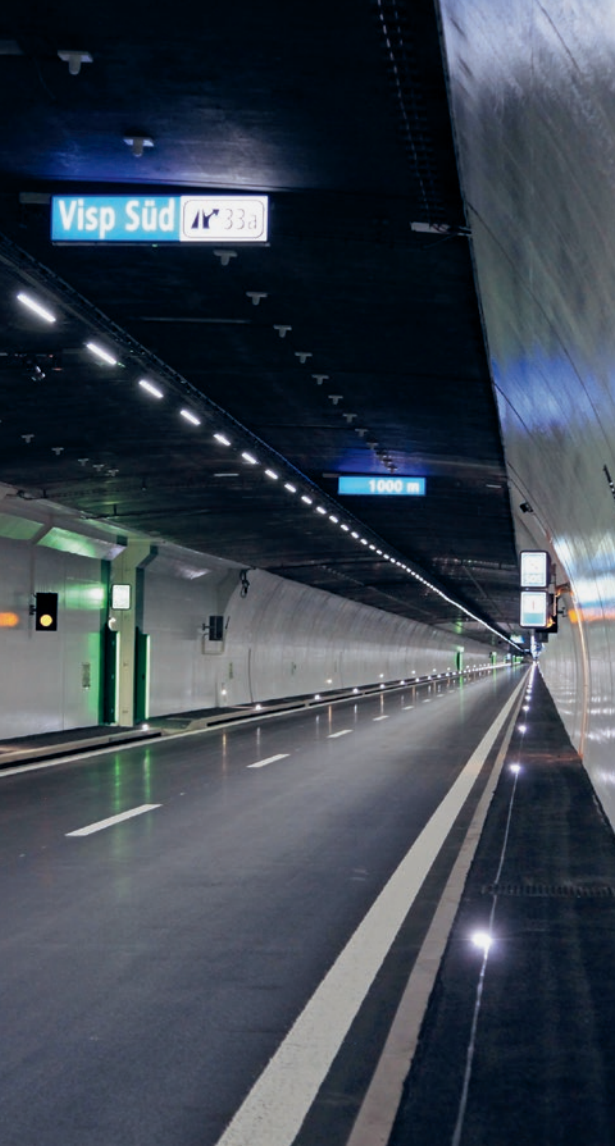
Nur noch alles testen: Südröhre des Tunnels Visp vor der Eröffnung
