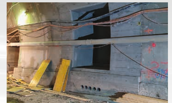
Neubau bzw. Umbau von SOS-Nischen , zum Teil kombiniert mit Hydrantennischen.
