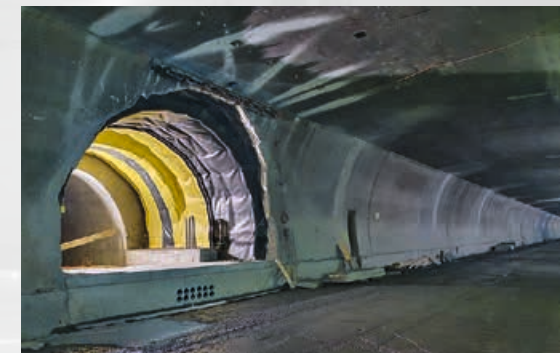
Erstellung der westlichen Anschlussbauwerke der 8 Querverbindungen zur fertigen Nordröhre des Tunnels Visp.
