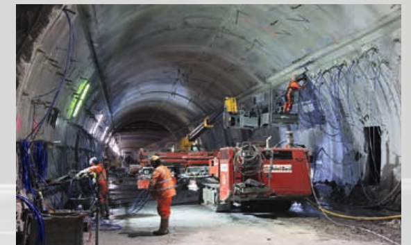
Rückbau und Neubau der Tunnelverkleidung (inkl. Zwischendecke und Bankette). Aufgrund des hohen Bergdruckes muss die bestehende Tunnelverkleidung vor dem etappierten Rückbau mit Ankern stabilisiert und gesichert werden. Neubau der Zwischendecken ab April 2022.
