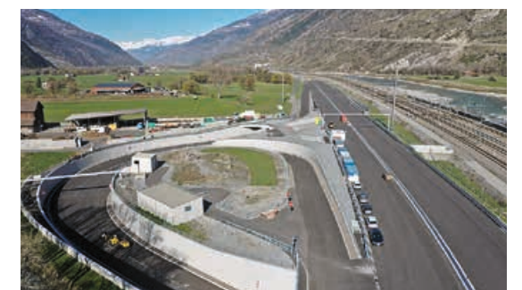
Letzte Arbeiten am Vollanschluss Visp West.
