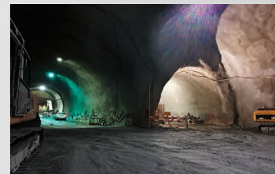
Bau der Verzweigung II (Verbindung des bestehenden Vispertaltunnels mit der neu erstellten Aufweitung im Bereich der Südröhre Richtung Chatzuhüs). Die bergmännischen Arbeiten sind seit Februar 2021 ausgeführt.
