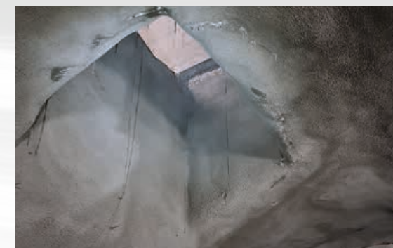
Bauliche Arbeiten für die Tunnellüftung im Ereignisfall: - Bau eines neuen Lüftungsschachtes in der Nähe des Tunnelportals Schwarzer Graben - Schliessen von bestehenden Lüftungsschlitten - Bau von neuen Abluftklappen in die Zwischendecke - Einbau von Strahlventilatoren im Fahrraum
