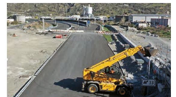
Bau einer Lärmschutzwand aus Steinkörben. Die Ausfahrt ist bereits signalisiert.
