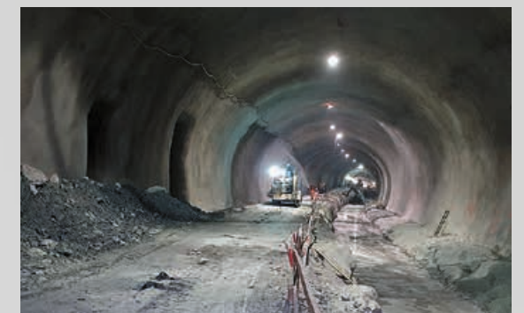
Einbau eines begehbaren Werkleitungskanals (WLK) in der Tunnelsohle. Rechts im Bild: 2.5 m tiefe Baugrube.
