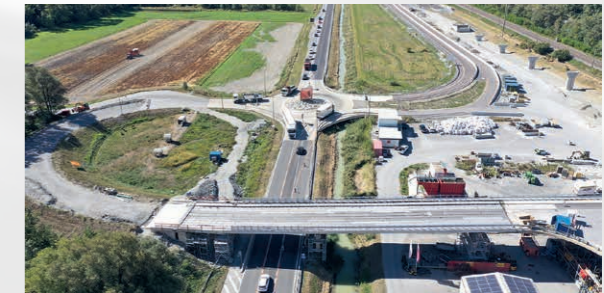
Das Widerlager Süd musste komplett neu gebaut werden.
