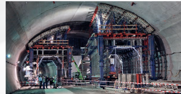
Imposante Gewölbeschalung in der Verzweigung III.
