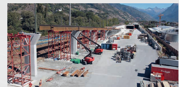
Die heute fertiggestellte Ostrampe im Bau. Dies ist die künftige Anbindung des Verkehrs Ost-West, die vom Gedeckten Einschnitt Raron auf die Brücke führt, um die Autobahn in Raron zu verlassen.
