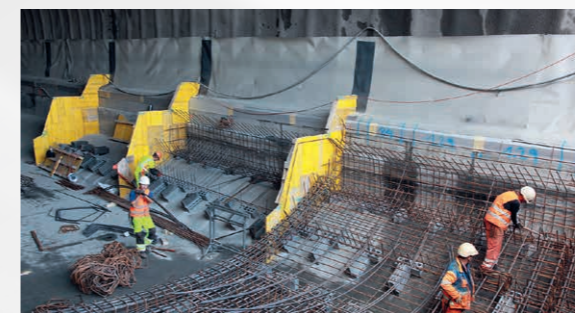
Verlegen der Armierung und Montieren der Abschalung für das Sohlgewölbe.
