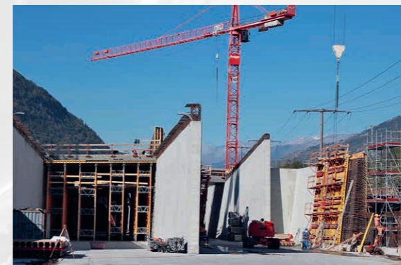
Insgesamt wurden 87'530 m 3 Beton verbaut.
