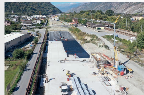
Verlegen der Abdichtungsfolien auf der Tunneldecke.
