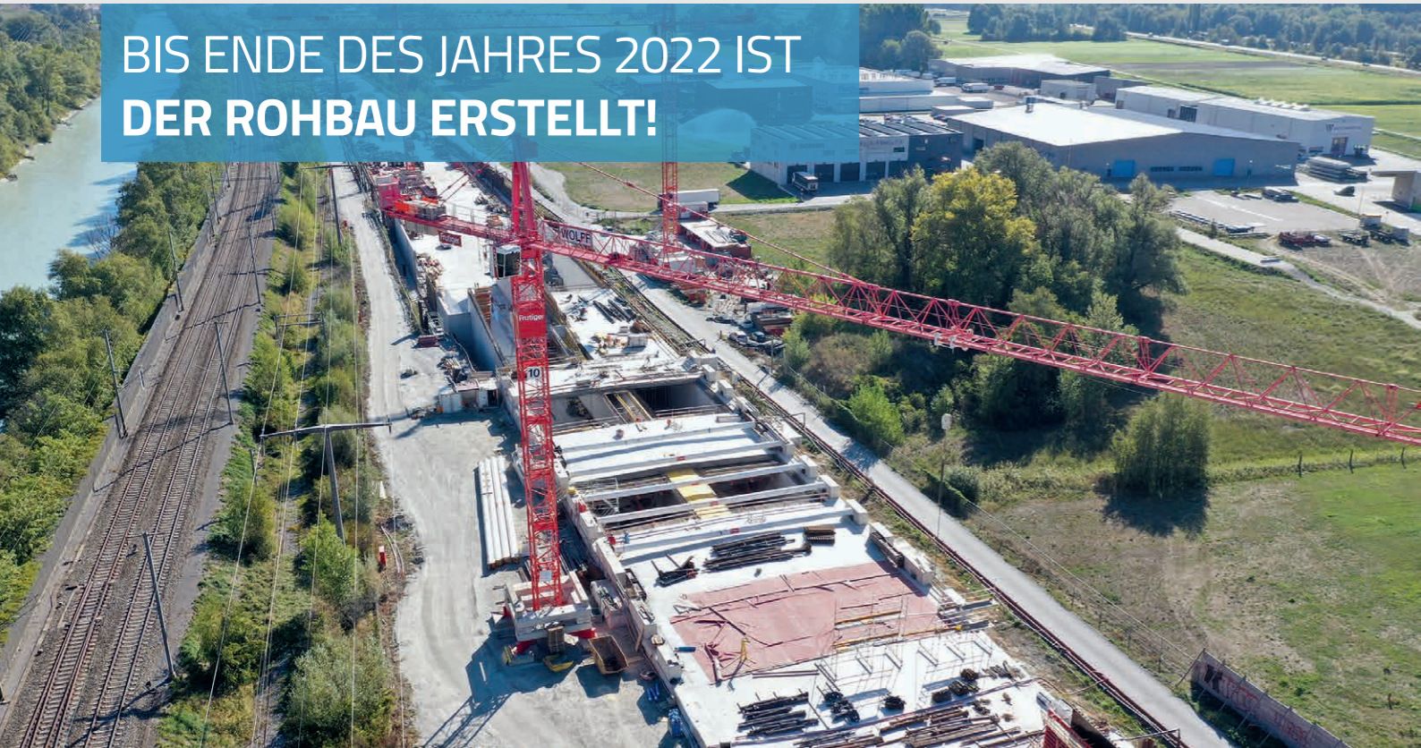
Die letzten Meter Beton beim Ostportal des GERA.
