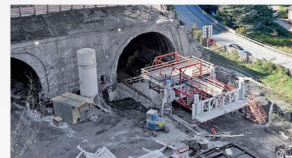
Der Schalwagen zum Betonieren des Sohlgewölbes stand im Oktober 2022 vor dem Ostportal des Tunnels Nord.
