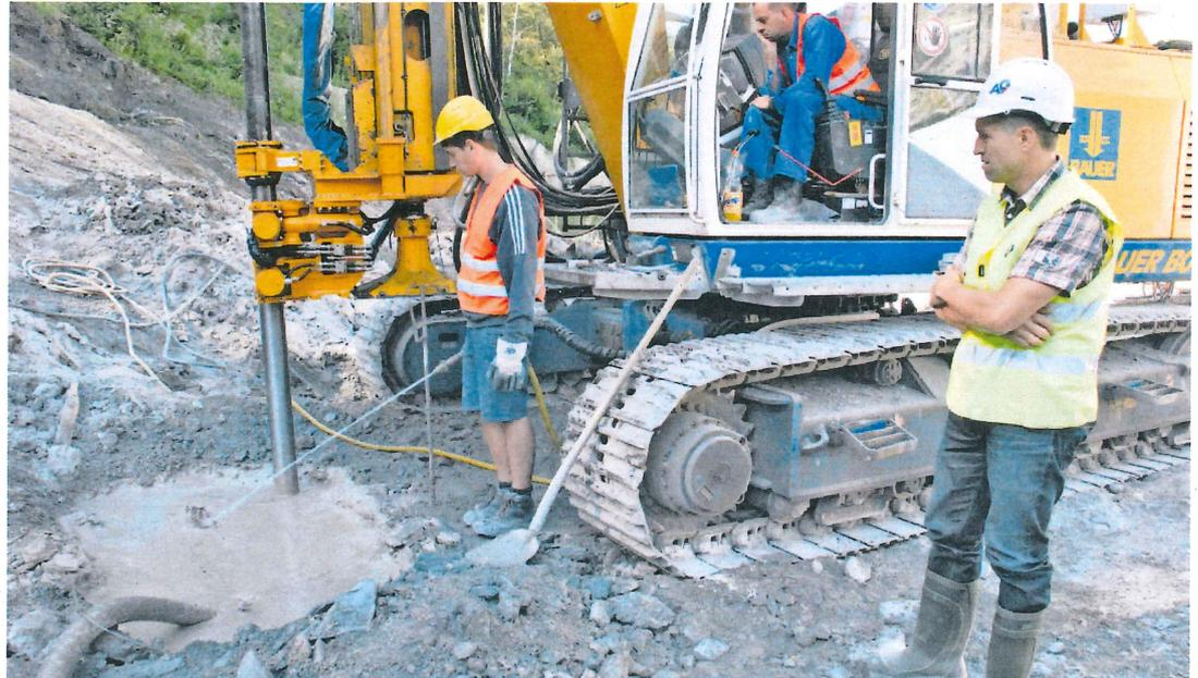
**Unter Druck.** Oberbauleiter Eugen Schmid (rechts) verfolgt nach der Fertigstellung einer Jettingsäule das Abpumpen des überschüssigen «Bodenbetons», der beim Rückzug des Gestänges an die Oberfläche gedrückt wird.
