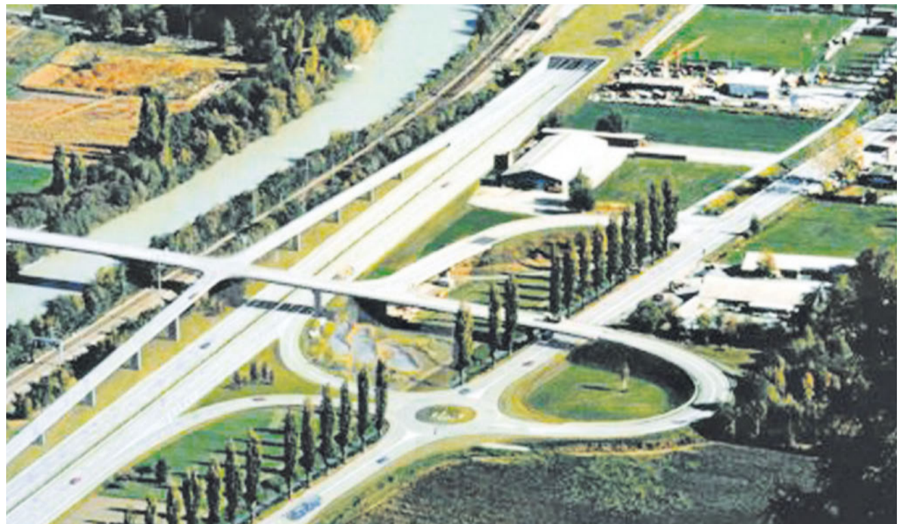
Vollanschluss Raron. Die Fotomontage zeigt, wie sich die Autobahn allmählich in den Tunnel hinab absenkt und das System der Zu- und Abfahrten ab der Autobahn. FOTOMONTAGE ZVG
