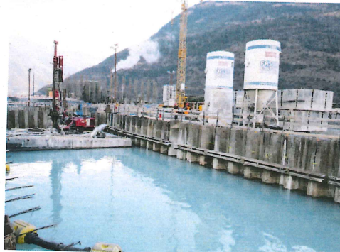
Grundwassertümpel. Eines von mehreren Bassins, dessen Grund die Industrietaucher betonieren müssen.
