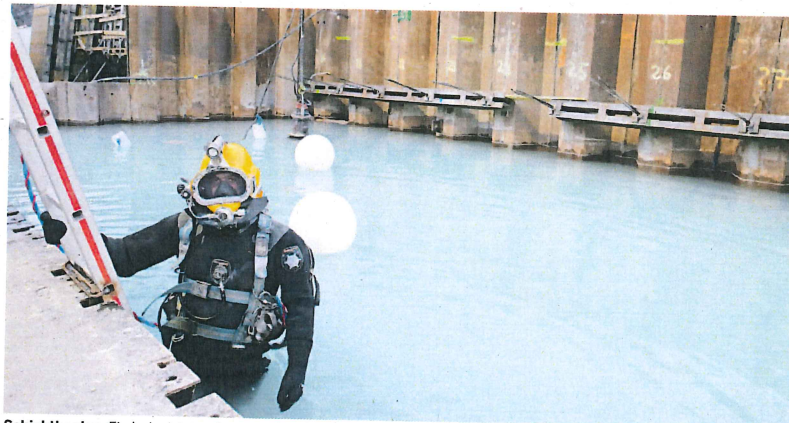
Schichtbeginn. Ein Industrietaucher macht sich auf der Visper Autobahnbaustelle an die Arbeit.
