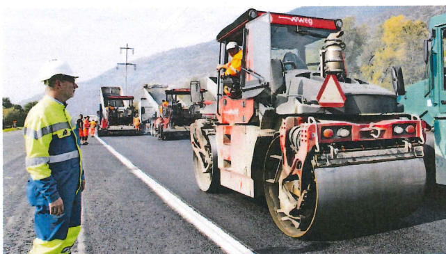
Eindrücklich. Drei Fahrspuren werden gleichzeitig unter Beobachtung von Martin Hutter asphaltiert.
