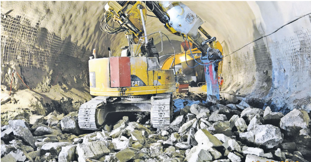
Blick in die Röhre. Die Arbeiten am Tunnel Visp laufen auf Hochtouren.
