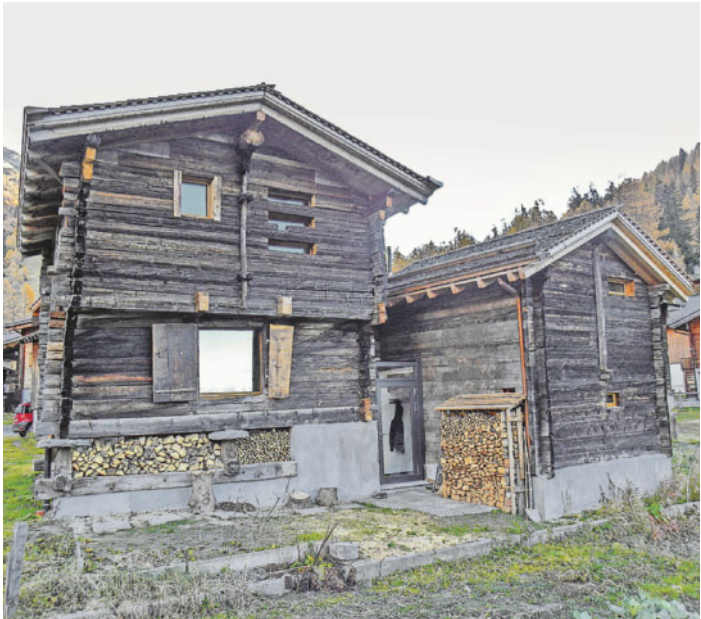
Bremsklotz. Umnutzungen von alten Ökonomiegebäuden werden durch Rechtsunsicherheiten ausgebremst.
