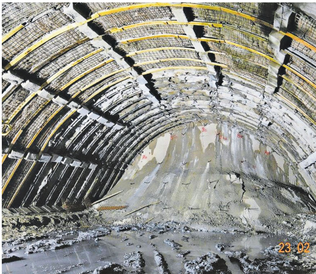
Gesichert. Die Stabilisierung des niedergebrochenen Materials dauert noch bis zu vier Wochen.
