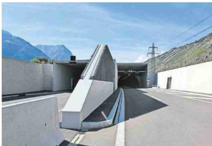
Kostspieliger Kompromiss. Der bereits fertiggestellte gedeckte Einschnitt Turtmann verschlang 300 Millionen Franken. FOTO ZVG
