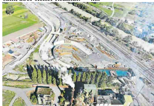
Ausgeklügelt. Der Vollanschluss verläuft wie ein Schneckenhaus.
