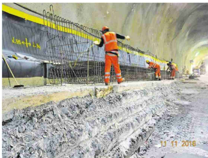
Voller Einsatz. Die Mitarbeiter der ARGE sind zurzeit mit der Innenverkleidung des Tunnels Visp beschäftigt.
