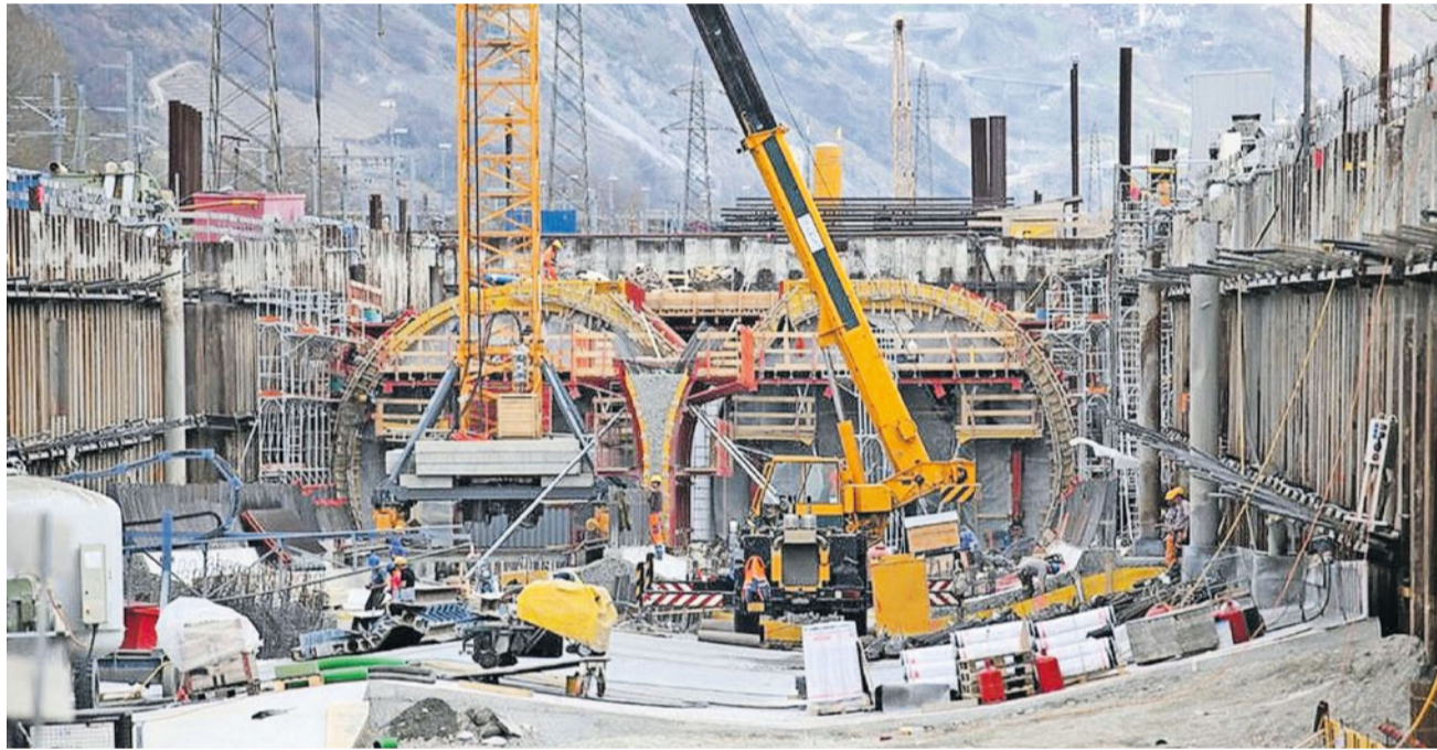
«Turtmann II». Wie in Turtmann wird die Autobahn durch das Dorf Raron in einem gedeckten Abschnitt geführt. ARCHIVBILD AG
