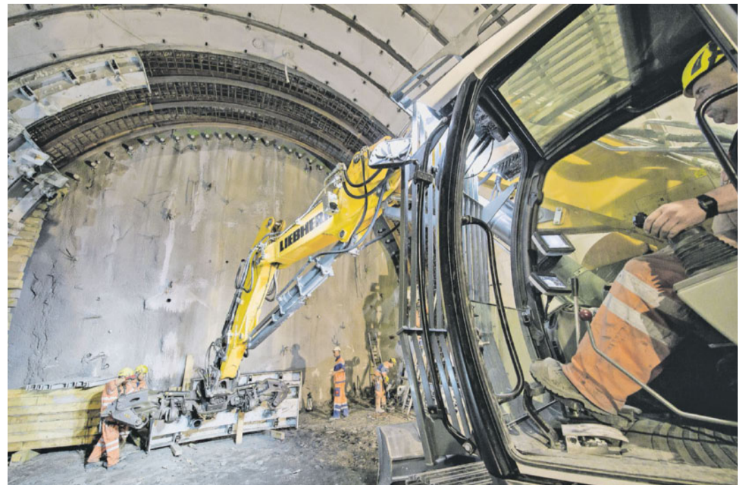
Heikle Geologie. Montage von stählernen Schalungselementen in der nördlichen Tunnelröhre.
