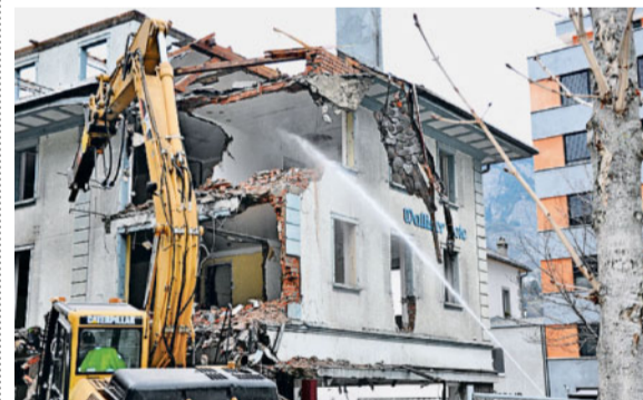
Das Ende. Das blaue WB-Haus an der Furkastrasse 21 gibts nicht mehr. Neues, Modernes entsteht.
