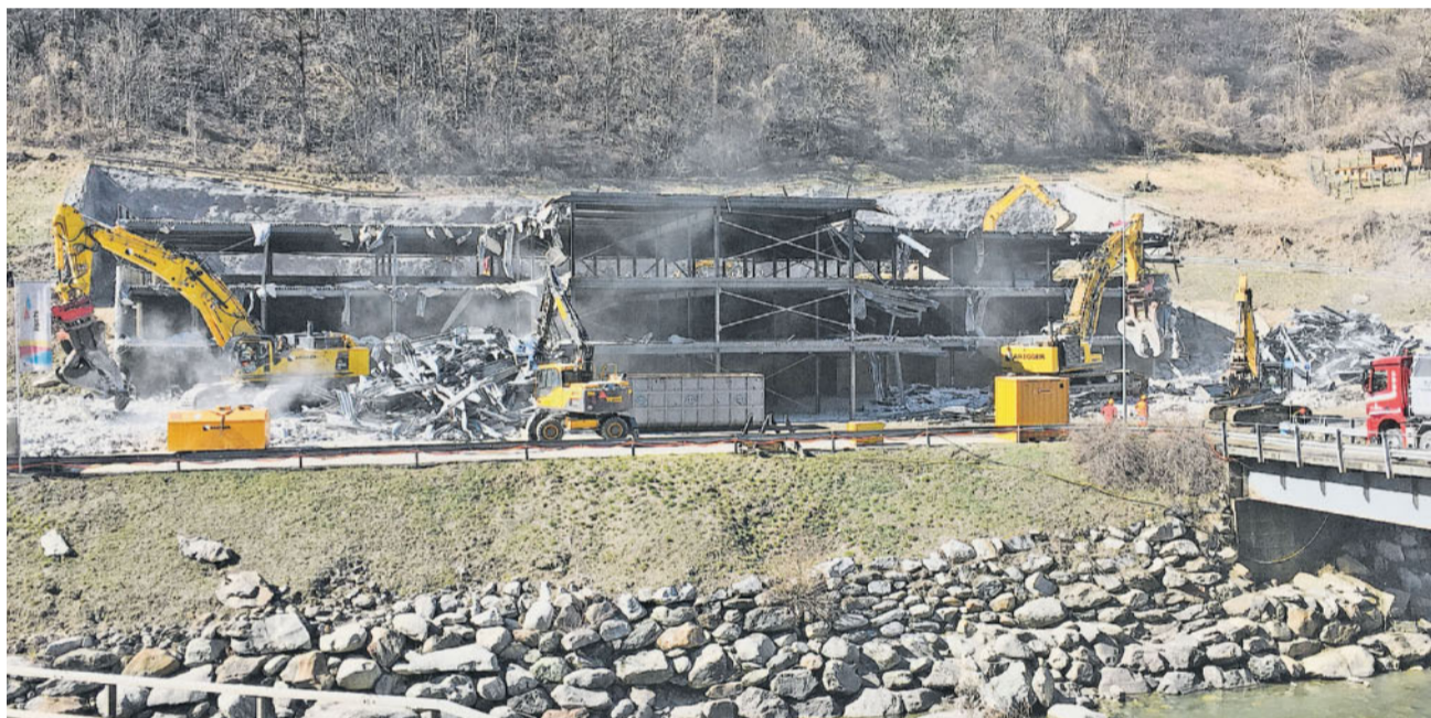
Abgebrochen. Am 16. März waren die Abbrucharbeiten in vollem Gang. Inzwischen ist das alte Parkhaus vollständig von der Bildfläche verschwunden.
