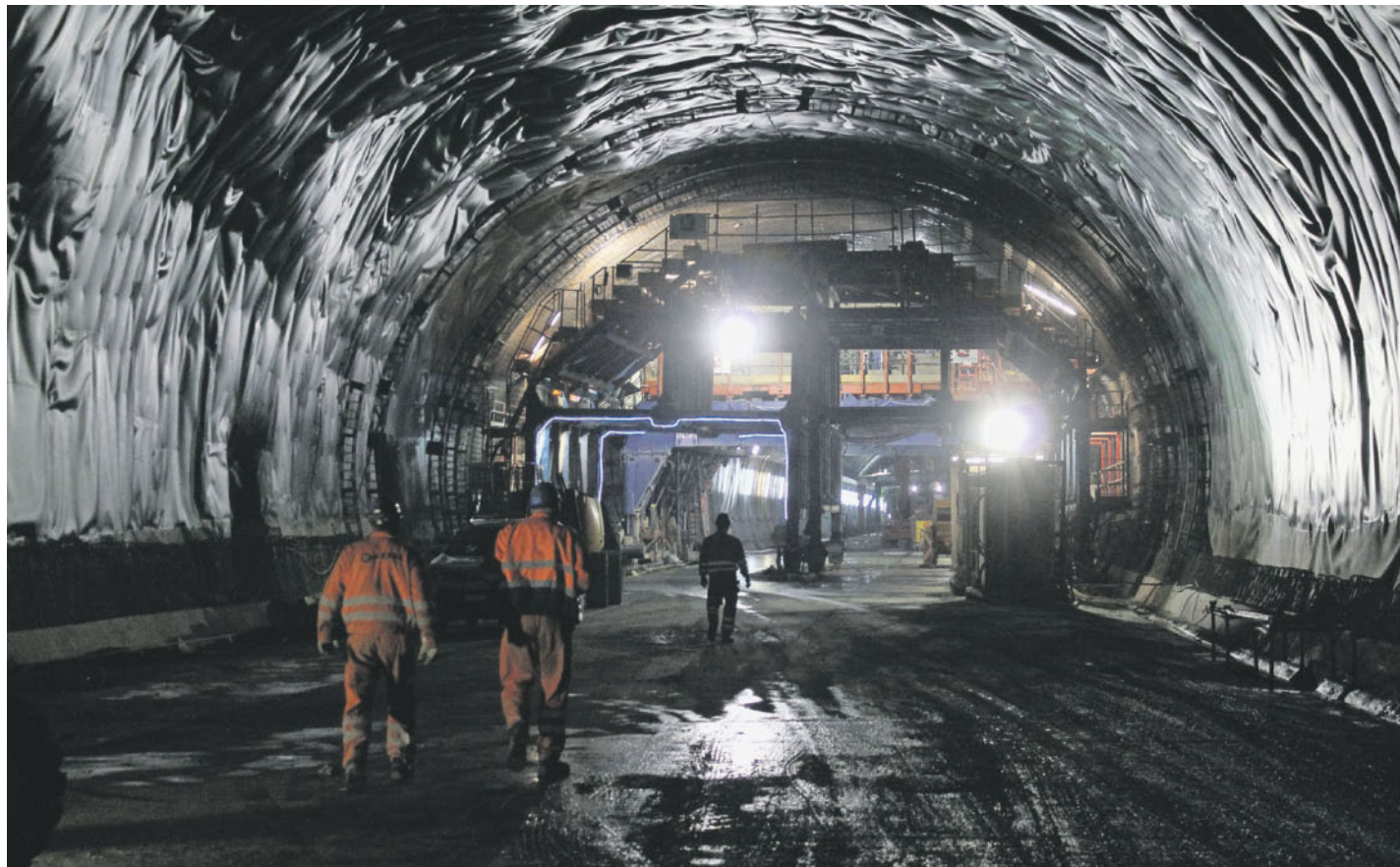
70 Prozent. Inzwischen sind mehr als zwei Drittel der Nordröhre des Tunnels Visp mit Beton verkleidet.
