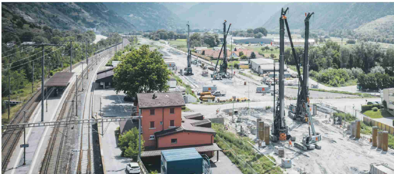
Blick nach Osten. Wo nun die Bohrtürme stehen, führt in einigen Jahren die A9 mitten unter Raron hindurch.
