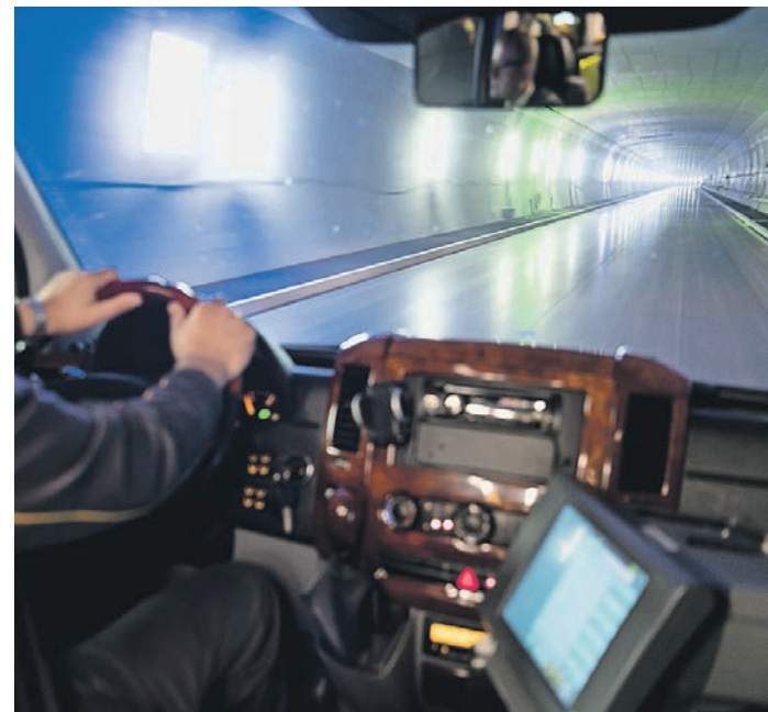
Fast fertig. Fahrt durch die Nordröhre des Vispertaltunnels in Richtung Visp West.
